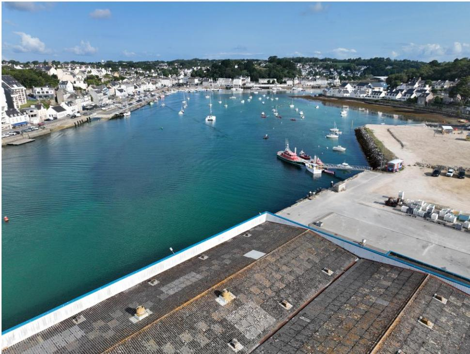
Construite dans les années 1970, la criée du port d'Audierne possède une toiture vétuste faite de tôles ondulées en fibro-ciment.
