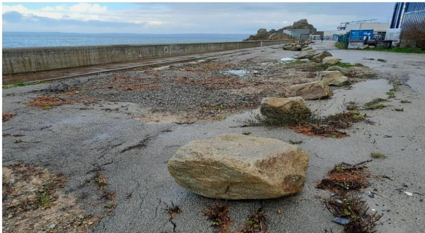
Depuis plusieurs décennies, le terre-plein du Flimiou subit des fuites de matériaux liées à la nature sédimentaire du remblais qui le constitue et au mode de fondation du môle (construit sur des enrochements durant les années 1940). Le projet de remplacement du Slipway (construit en 1965) par un élévateur à bateaux moderne, nécessite que ces désordres soient traités afin de permettre la circulation de l'élévateur et des engins en toute sécurité.
