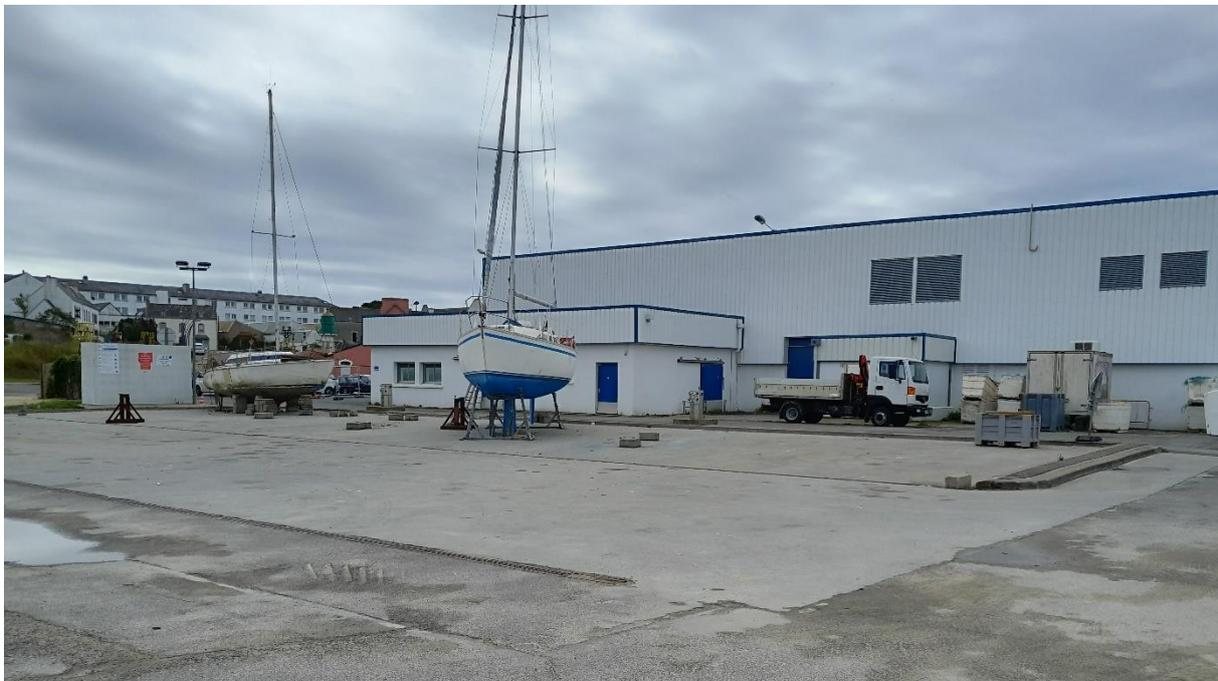
La pente ramène les eaux de carénage et pluviales dans un caniveau situé au centre de l'aire sur un axe ouest-est. Les eaux sont alors dirigées par 3 galeries, placées au centre et aux extrémités ouest et est du caniveau, vers un bassin tampon couvert de 18 m<sup>3</sup> situé en bordure sud de l'aire.
