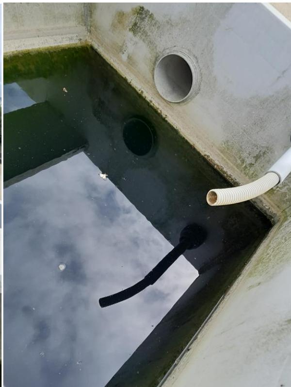
La station ne donne pas satisfaction tant sur les résultats des analyses d'eau (principalement sur les MES et métaux lourds), que sur les conditions de maintenance et des pannes fréquentes sur les pompes de relevage.
